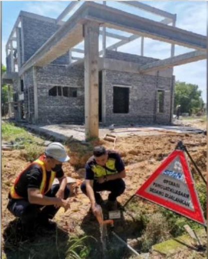
Kakitangan SAINS dan SPAN memeriksa sambungan air dilakukan kontraktor dipercayai mencuri air terawat SAINS untuk kerja membina banglo di Mantin.
